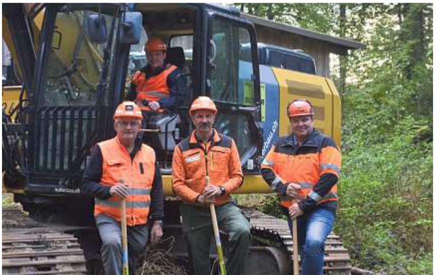
Spatenstich im Badwald, v.l.: Hanspeter Müller (Baumeister Sutter Bau AG), Hansueli Eugster (Förster Burggemeinde), Christoph Sutter (Mitinhaber Sutter Bau AG); im Bagger-Führerstand: Hans-Jörg Moser (Bürgerpräsident).
