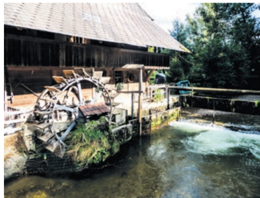
Bei der «Bleiki» befindet sich ein Wasserrad mit Transmission (Riemengetriebe)
